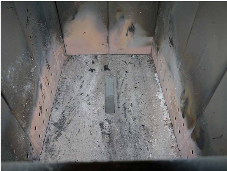
Bild 6. Richtig gereinigte Ladungskammer
