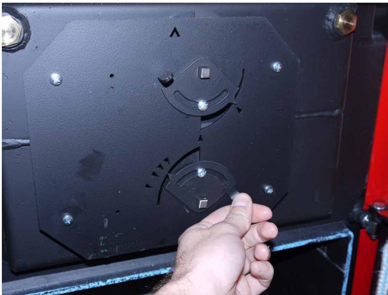
**Die Einstellung des Kessels DPX für die Verbrennung von Holz (Primär- und Sekundärklappe - geöffnet).**
